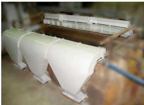
Рис. Бортовые отсосы из полипропилена, установленные на гальванической ванне
