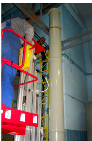
Рис. Монтаж вентиляционной системы
